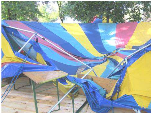
Das Dach des Küchenzelts nach dem Sturm
